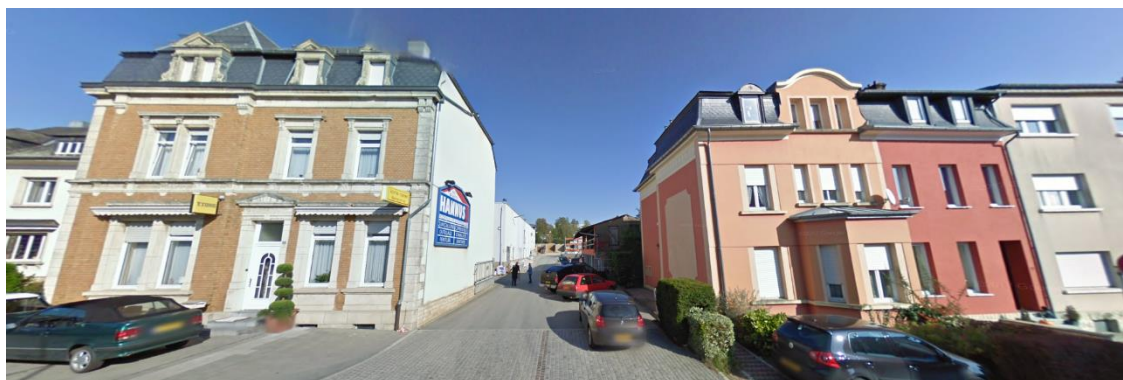
Photo 1 : vue sur les 2 maisons existantes de la "rue Joseph Muller" et l'accès au futur PAP (Source : Google Street-view)
